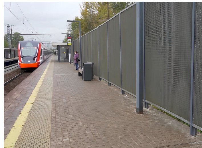
Московская область, МЦД Красногорская, огорождение с использованием настилов
